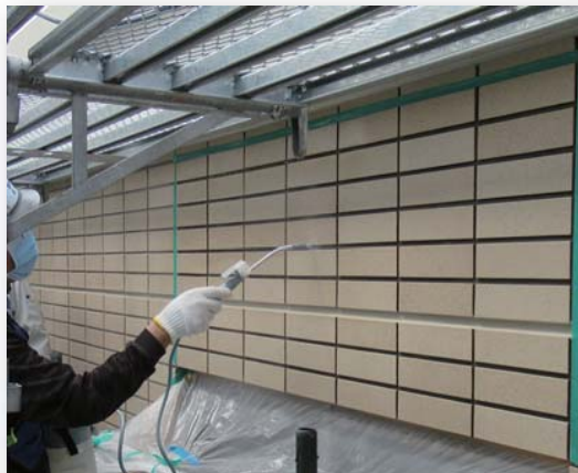
低圧噴霧器での施工
