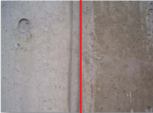
塗布浸透処理 (吸水による濡れ色無し) 無処理 (吸水による濡れ色有り)
